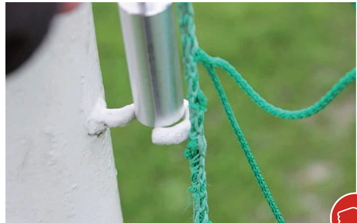
Bild 35: Offener Metallnetzhaaken mit Öffnung < 25 mm
