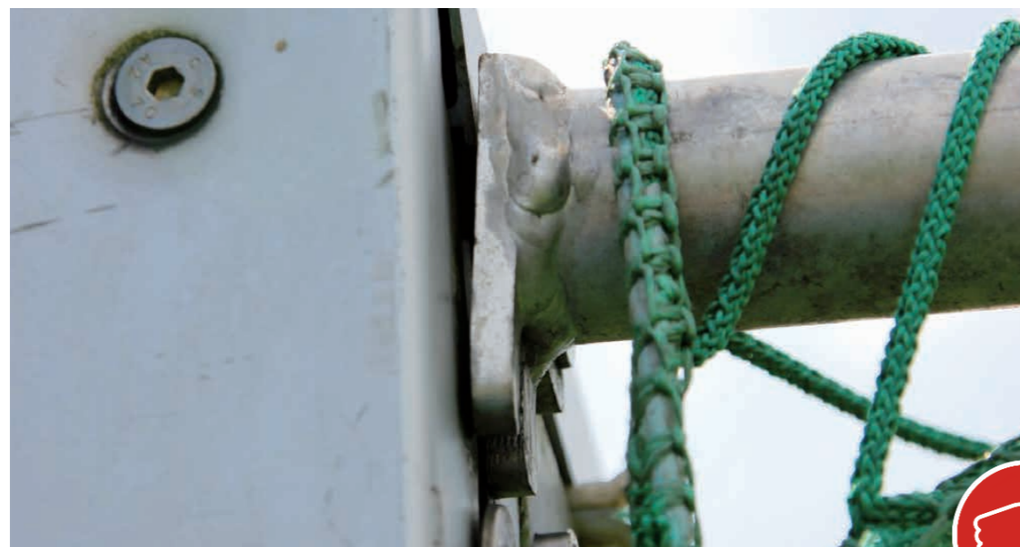
Bild 12: Fehlende Verbindung zwischen Pfosten/Querlatte und Netzkonsole
