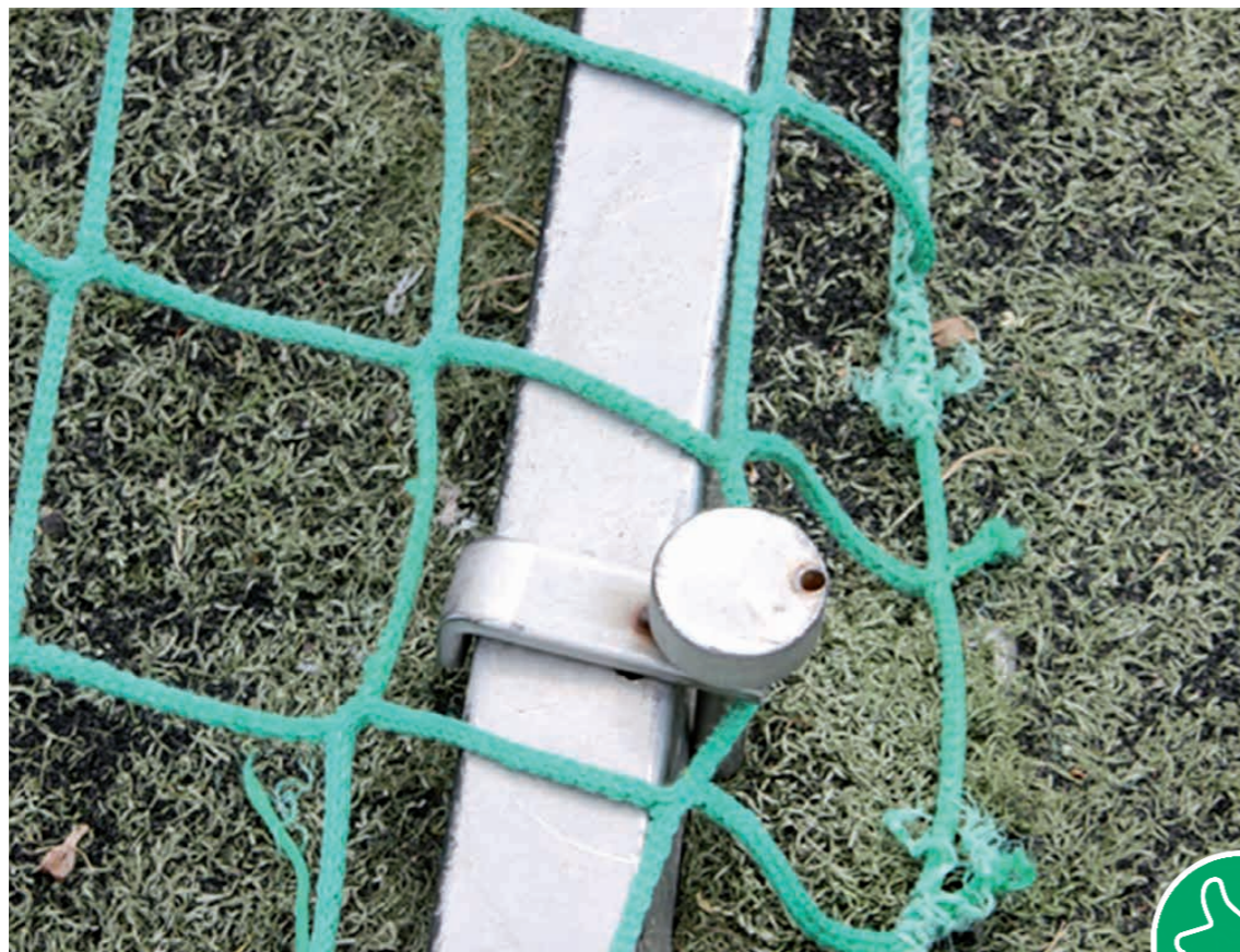
Bild 8: Befestigung mit Klemmbodenhülsen
