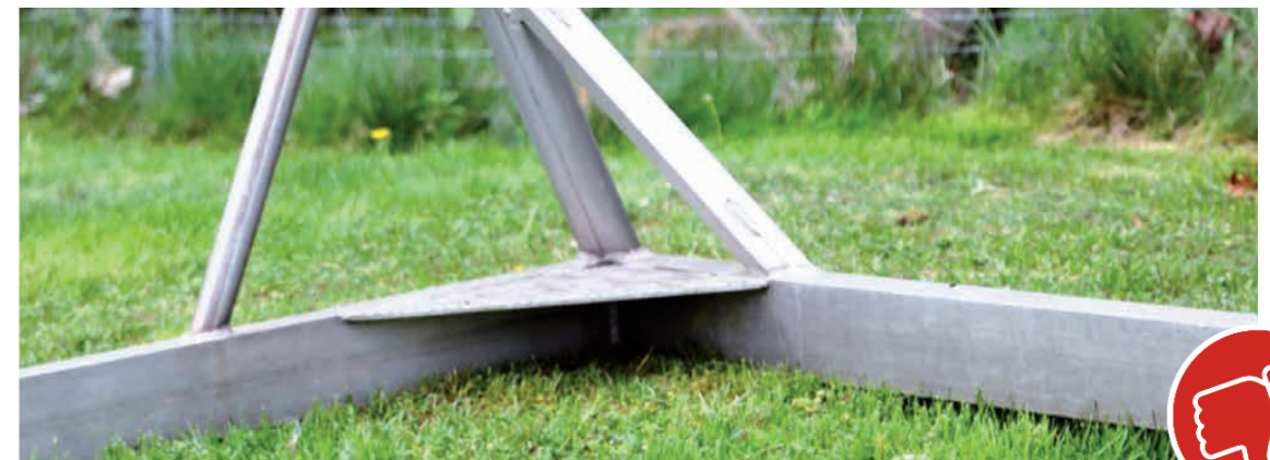
Bild 28: Eingeschweißter Winkel stellt erhöhte Verletzungsgefahr dar
