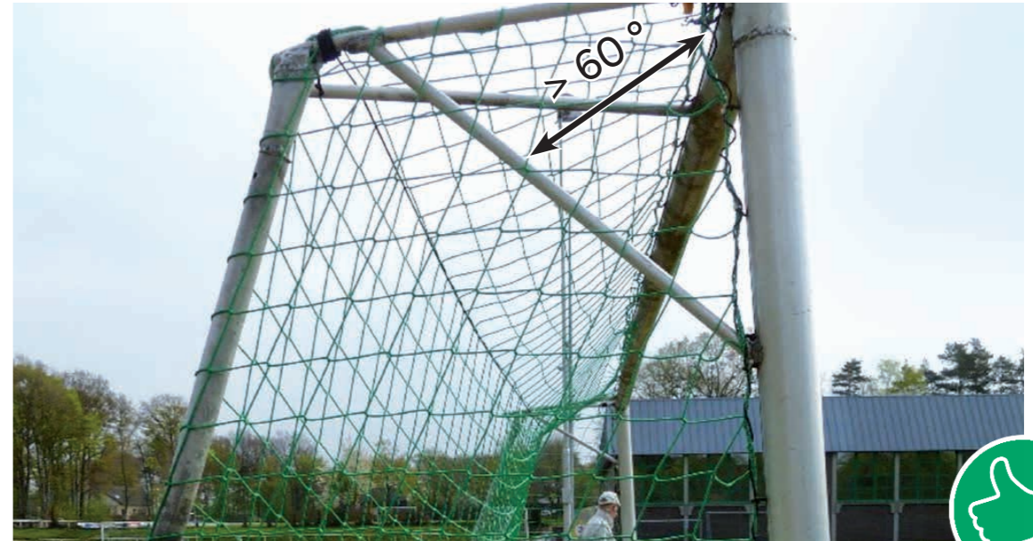
Bild 21: Nach oben geöffnete Winkel müssen > 60^\circ sein
