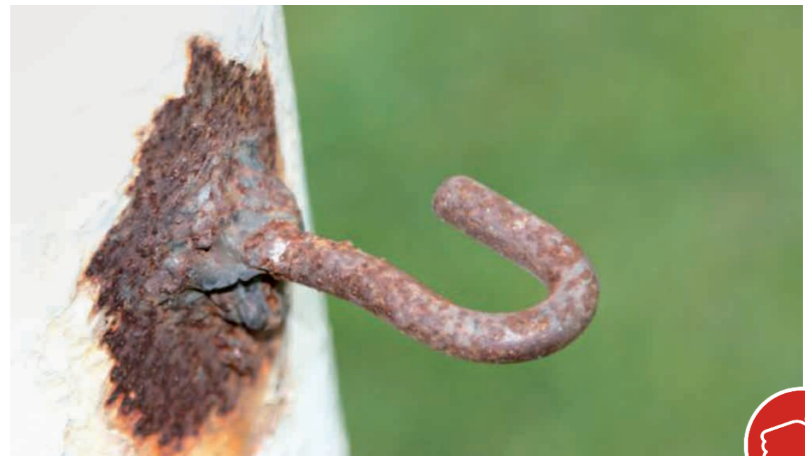
Bild 32a, 32b: Offene Metallnetzhaken sind nicht erlaubt.
