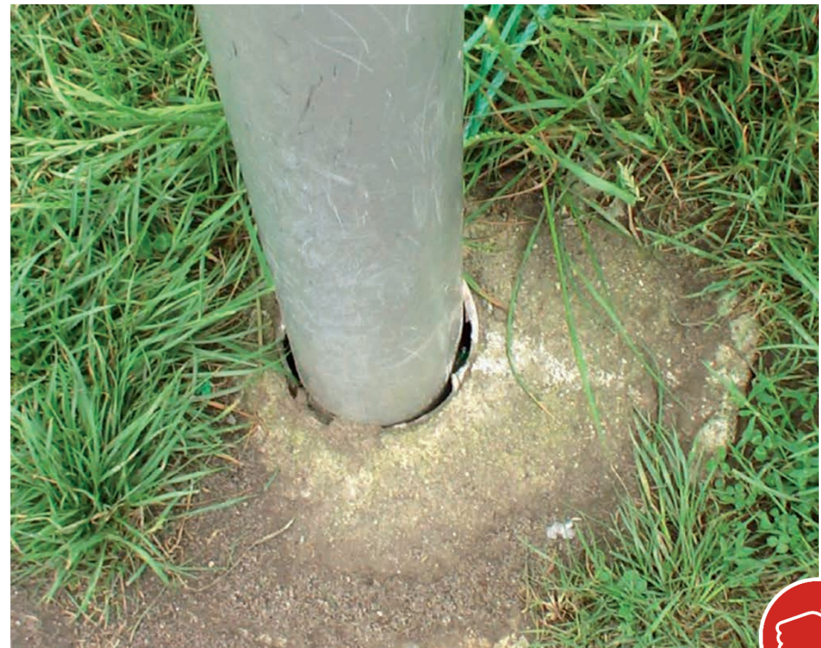
Bild 25: Fundamente sind mind. 4 cm zu überdecken
