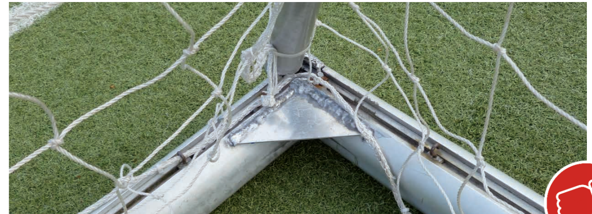
Bild 28: Eingeschweißter Winkel stellt erhöhte Verletzungsgefahr dar
